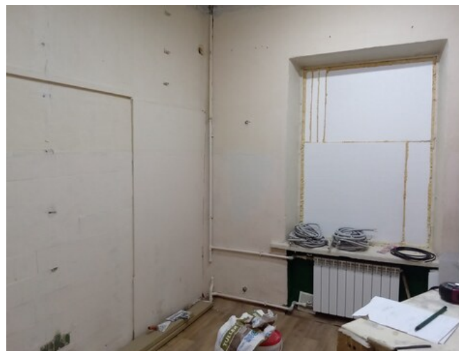
Ремонт помещения для занятий
