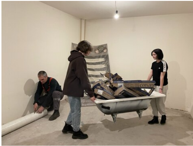
Монтаж напольного покрытия в лектории и вынос мусора
