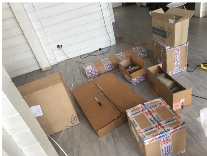
Упакованное демонстрационное оборудование и часть стройматериалов 22.08.2023 Октябрьская улица, 477Б
