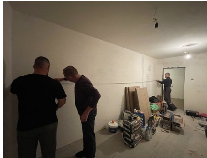
подготовка стен к выравниванию
