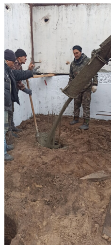
Строительство учебно-тренировочного полигона на участке, выделенном администрацией городского поселения города Павловска. Город Павловск, ул. Олега Кошевого, 1А. Октябрь 2023 года.
