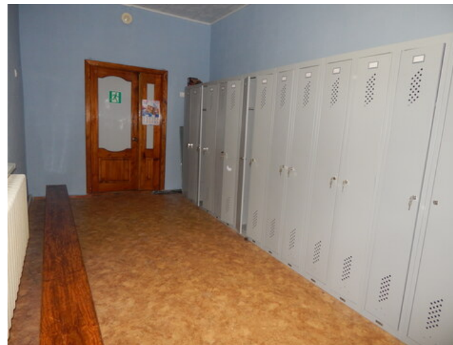
Раздевалка спортивного зала после ремонта и установки в ней шкафов для одежды.
