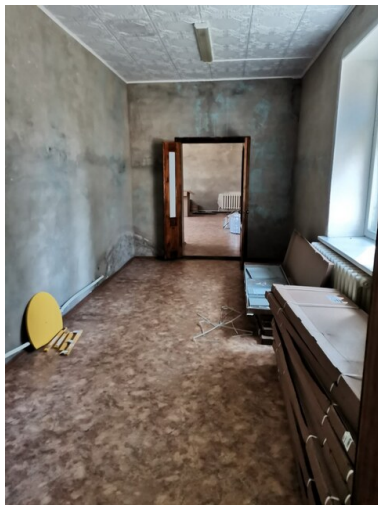
Раздевалка спортивного зала до ремонта
