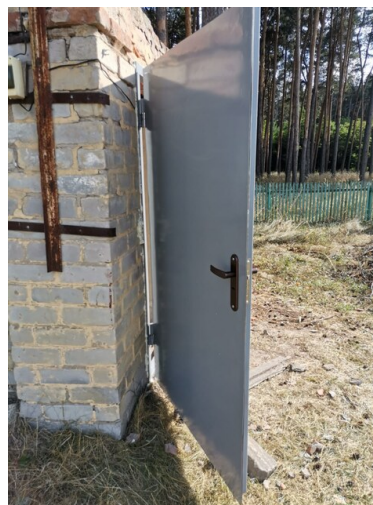
Металлическая входная группа в пневматический тир после установки
