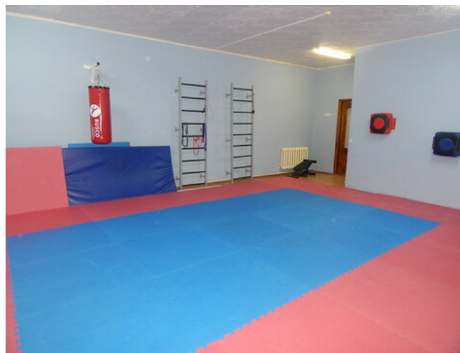
Спортивный зал после ремонта с напольным покрытием и установленным оборудованием: боксерский мешок, подушками настенными боксерскими, шведскими стенками, турниками-брусками.
