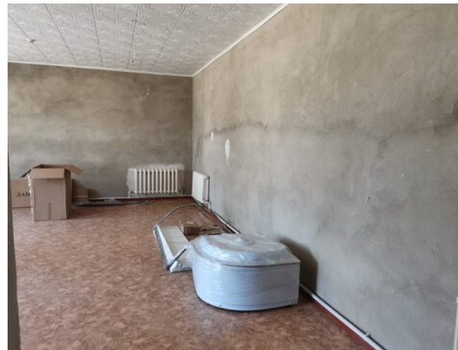
Спортивный зал до ремонта и установки оборудования
