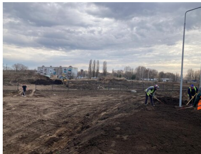
разравнивание грунта и вывоз мусора с территории проекта
