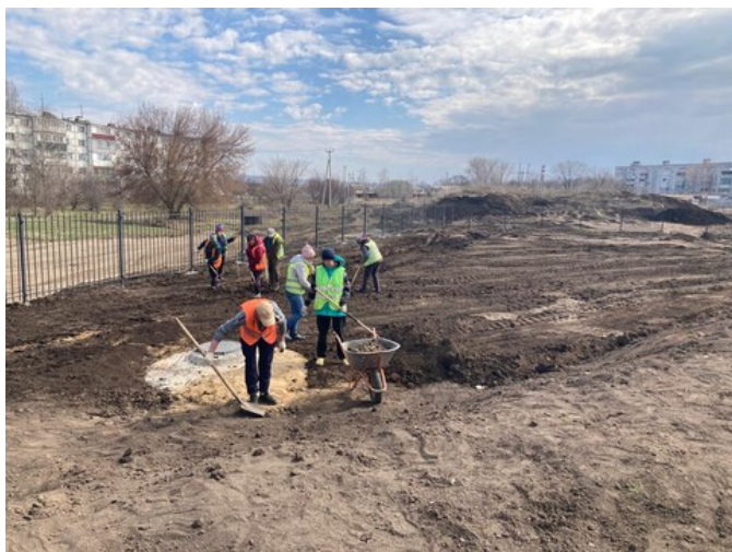
разравнивание грунта и вывоз мусора с территории проекта
