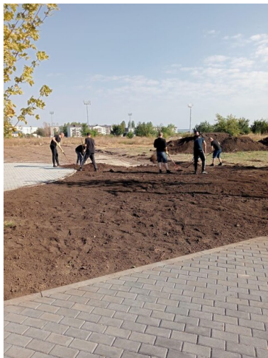
29.09.23 разравнивание грунта и вывоз мусора с территории проекта
