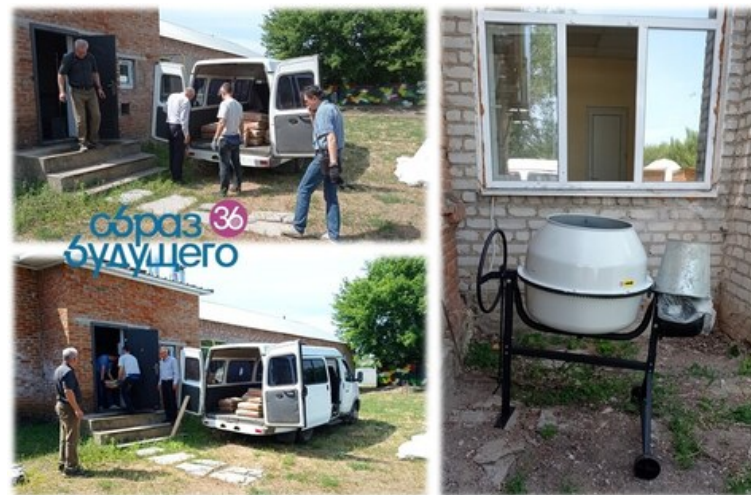
4 июня привезли цемент, приобретенный в счет софинансирования. На фото разгрузкой занимаются члены команды островерхов Г. и Дрога А. Привез в счет софинансирования добровольный помощник Грякалов В. Справа на фото стоит бетономешалка, которую тоже купили за счет софинансирования.
