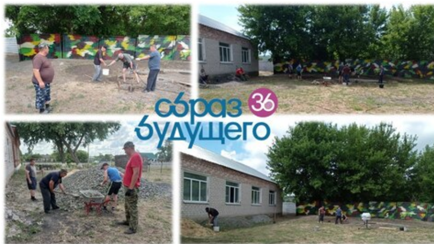
7 июня залили бетонную основу под сцену. На фото: работают 12 волонтеров (спортсмены района).
