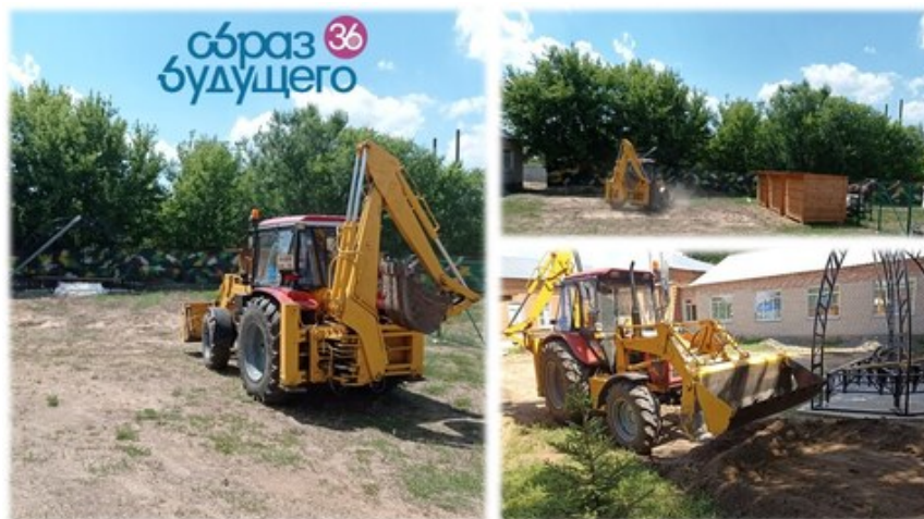
20 июня в счет софинансирования трактором была расчищена площадка под укладку плитки тротуарной.
