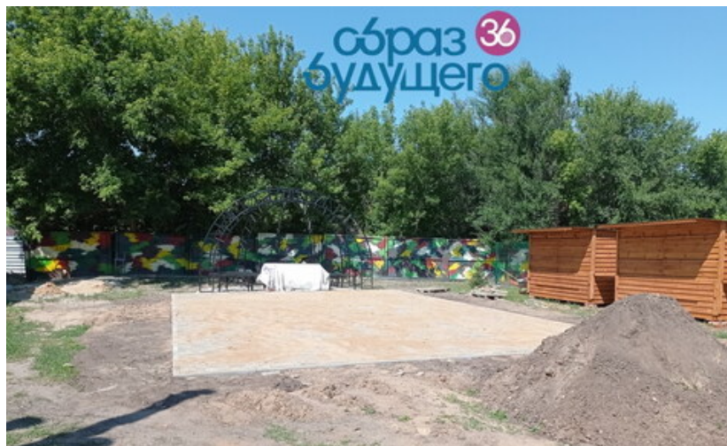
25 июля была закончена укладка плитки под скамейки. Плитка и работы по укладке производились за счет софинансирования.
