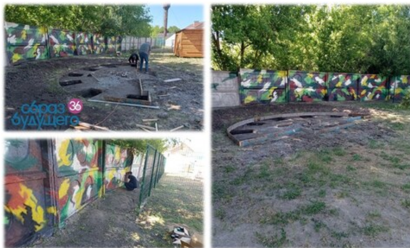
26-28 мая рыли котлован для заливки фундамента под сценический комплекс. На фото: работают 2 волонтера.
