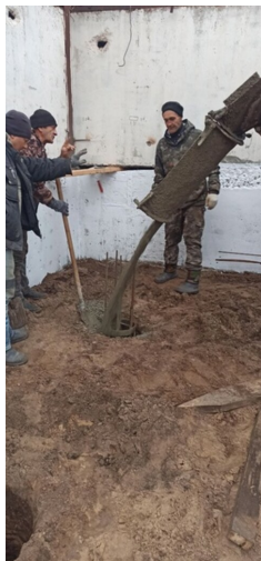
13-Бетонирование скважин под фундамент для металлоконструкций (октябрь 2023 года, г.Павловск ул. О.Кошевого, д.1а )
