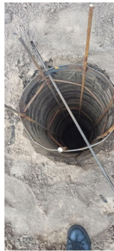
12-Подготовка скважин к бетонированию (октябрь 2023 года, г.Павловск ул. О.Кошевого, д.1а )
