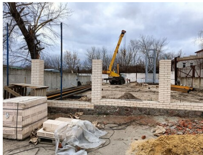
16-Строительство ограждения (декабрь 2023 года, г.Павловск ул. О.Кошевого, д.1а )
