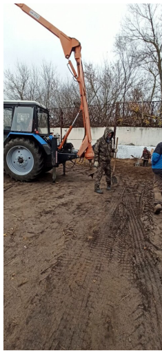
11-Бурение скважин (октябрь 2023 года, г.Павловск ул. О.Кошевого, д.1а )
