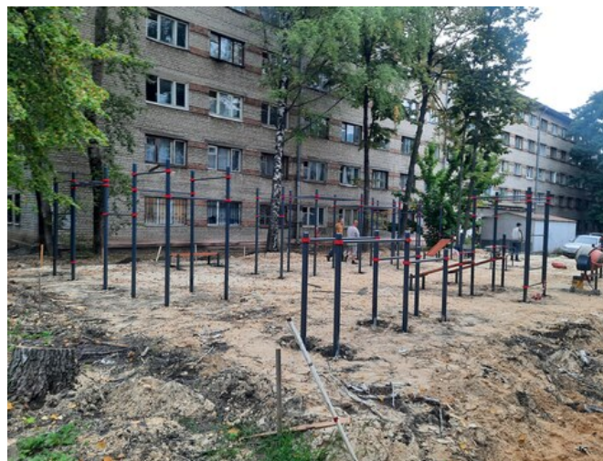
Спортивная площадка (подготовка) сентябрь 2023, г. Воронеж, ул. Березовая роща 26/28
