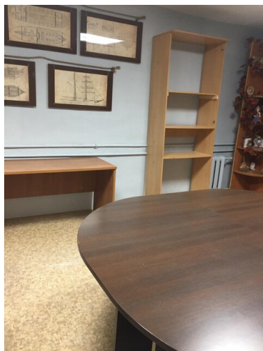
завершен ремонт помещения "Секретная лаборатория"
