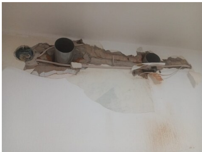
установка вытяжки в помещении "Секретная лаборатория"
