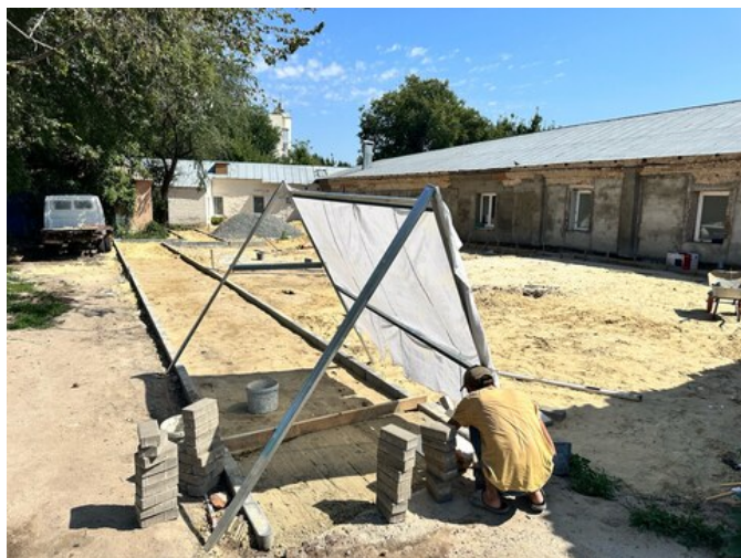
Строительные работы по обустройству площадки
