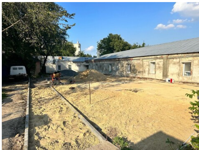
Строительные работы по обустройству площадки
