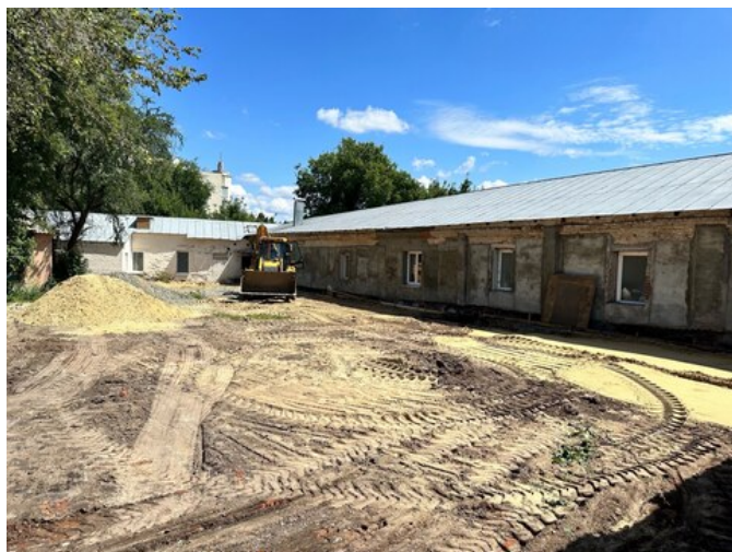
Строительные работы по обустройству площадки
