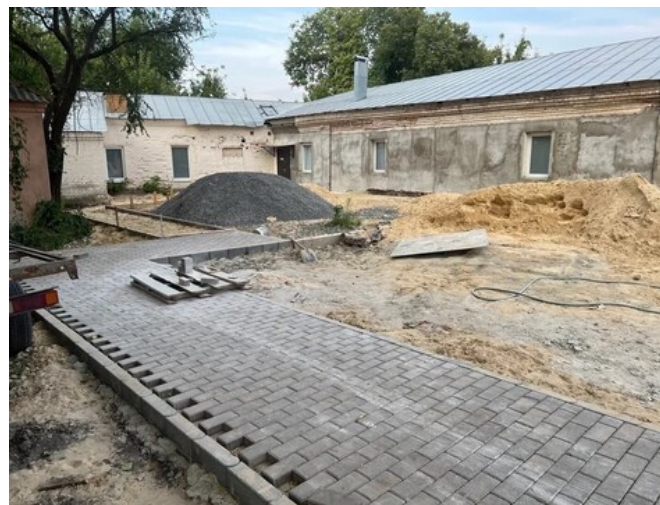
Строительные работы по обустройству площадки
