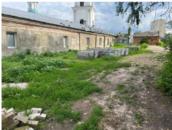
Строительные работы по обустройству площадки
