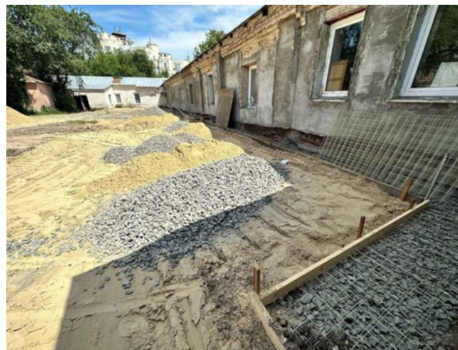
Строительные работы по обустройству площадки
