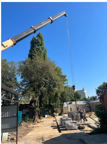
Строительные работы по обустройству площадки
