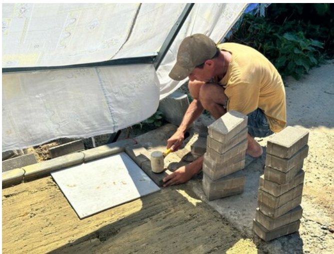
Строительные работы по обустройству площадки
