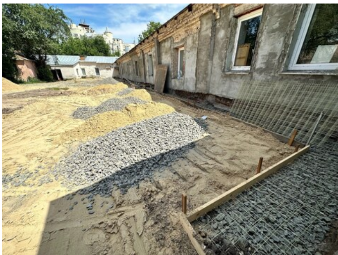
Строительные работы, август 2023 года, пер. Фабричный, 8
