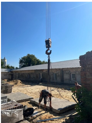
Строительные работы по обустройству площадки
