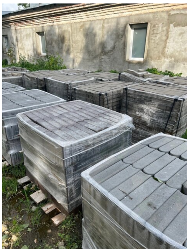
Строительные работы, август 2023 года, пер. Фабричный, 8
