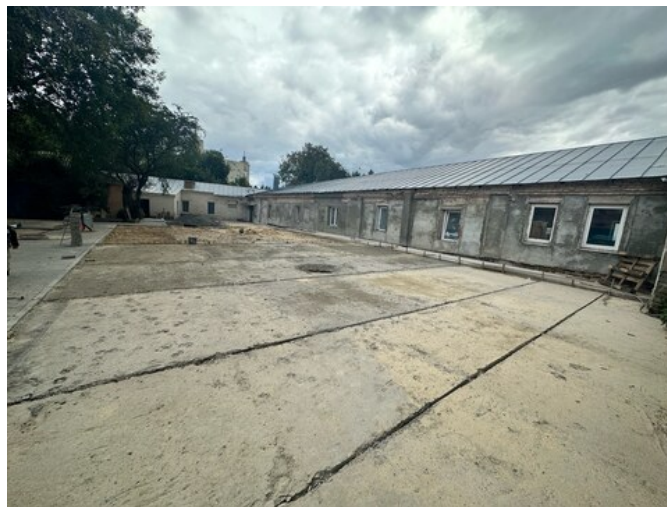
Строительные работы по обустройству площадки
