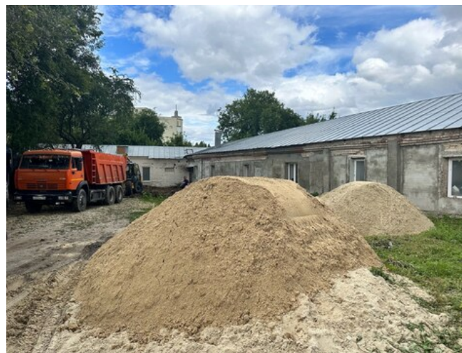
Строительные работы по обустройству площадки
