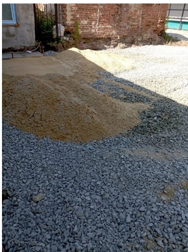
Строительные работы по обустройству площадки
