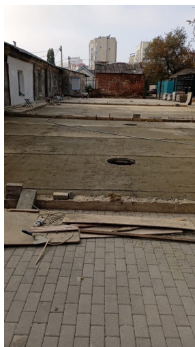
Строительные работы по обустройству площадки
