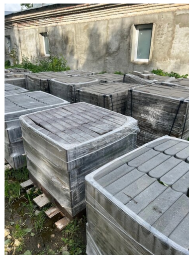
Строительные работы по обустройству площадки
