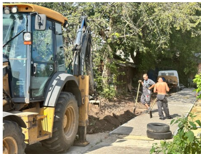
Строительные работы по обустройству площадки
